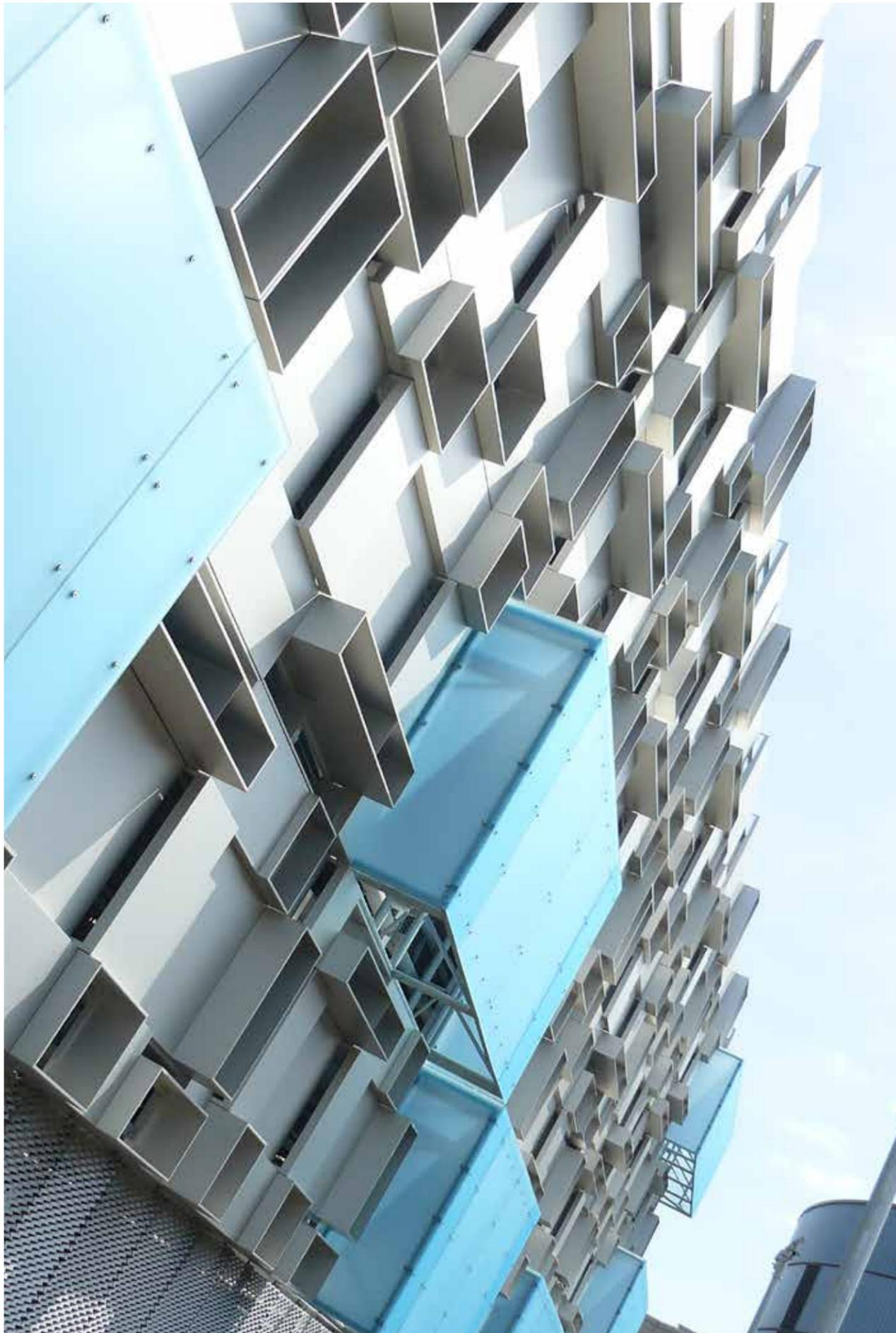
Fassadenelemente eines Parkhauses aus PERSPEX® Frost Arctic Blue S2 7T77 | ©Fotograf: Image Technique
